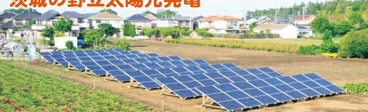
▲土浦市荒川沖 第一ひまわり発電所 野立 48kW（モジュール 250W・192 枚）一般家庭約 16 軒分の使用量 5 月 15 日から売電 工事費 1,680 万円。 20 年間の発電収入 1,995,840 円/年 × 20 年 × 0.92(効率低下分)=3,672 万円（予定）
