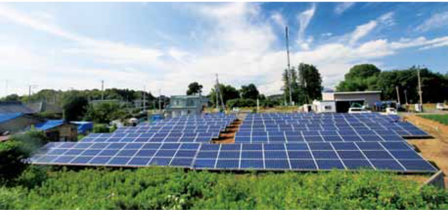
▲つくば市島名 ひまわり発電所 野立 108kW（モジュール 250W・432 枚）一般家庭約 36 軒分の使用量 9 月 7 日から売電 工事費 3,780 万円。 20 年間の発電収入 4,490,640 円/年 × 20 年 × 0.92(効率低下分)=8,262 万円（予定）
