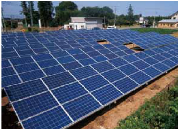
▲つくば市島名 ひまわり発電所 野立 108kW（モジュール 250W・432 枚）一般家庭約 36 軒分の使用量 9 月 7 日から売電 工事費 3,780 万円。 20 年間の発電収入 4,490,640 円/年 × 20 年 × 0.92(効率低下分)=8,262 万円（予定）
